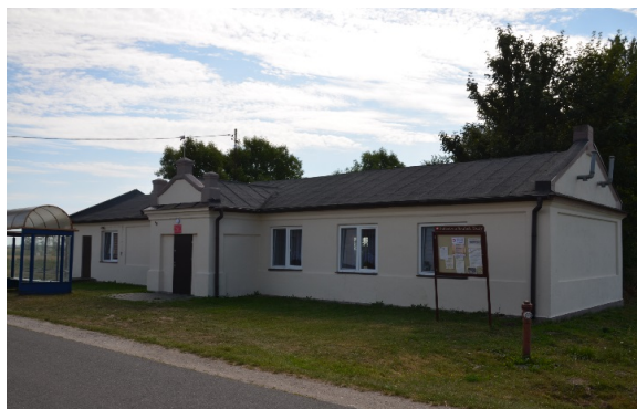
Aktualne zdjęcie Remizy Ochotniczej Straży Pożarnej
